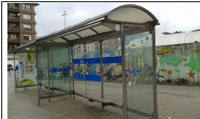
Zumalakarregi 27 Limpieza y arreglo
